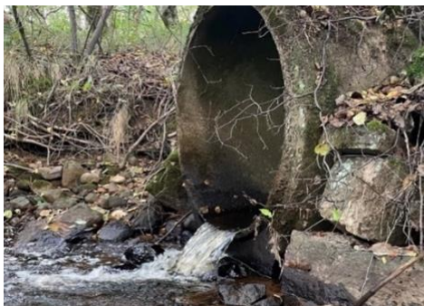
Figur 14. Vandringshinder 5 före och efter åtgärd.
