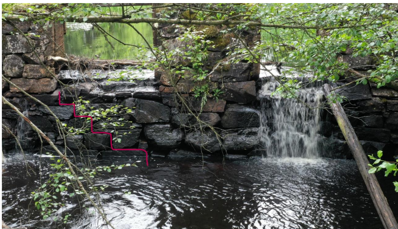
Figur 14 Exempel på hur stenar kan plockas bort "sten för sten" visas som rött streck i bilden.
