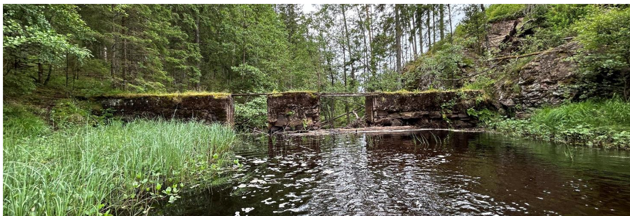
Figur 8 Uppströmssidan av dammen.
