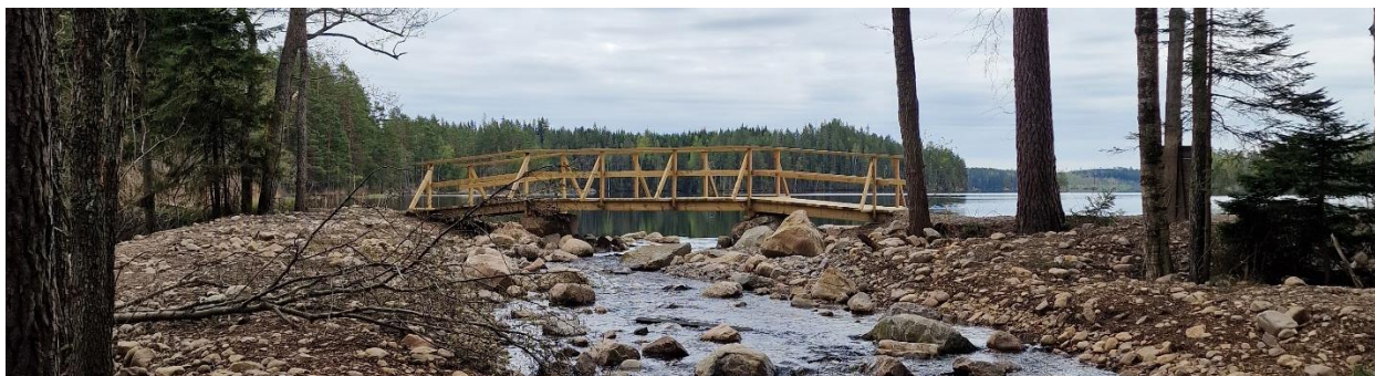
Figur 13 Ett exempel där en träbro anlagts för passage över ett sjöutlopp efter en dammutrivning.
