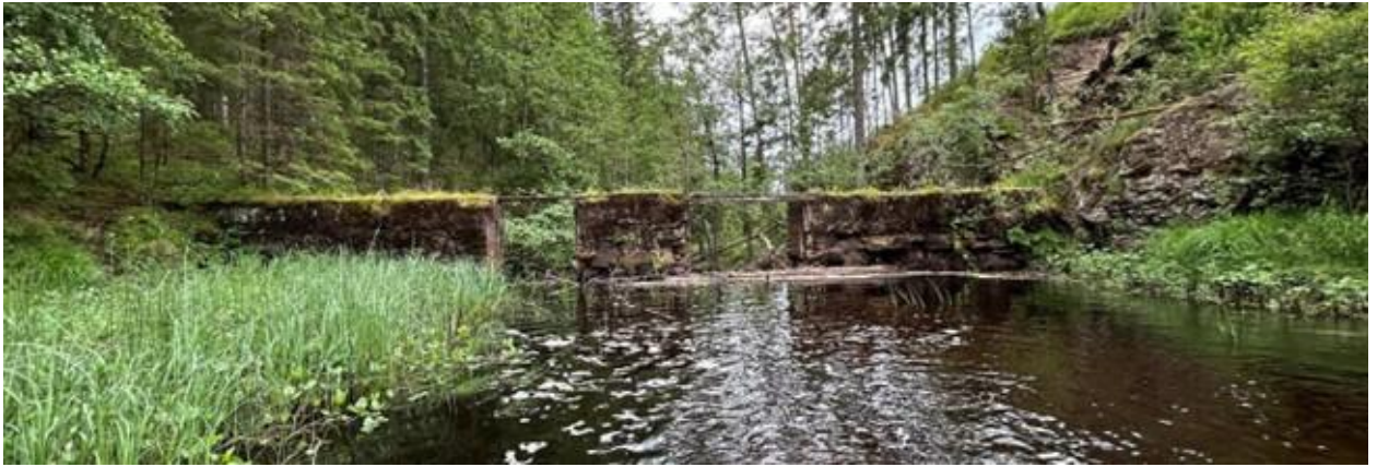
Dammvallens uppströmssida (Foto, Norconsult)
